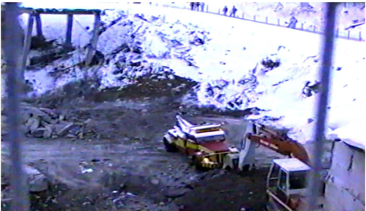
Fra Vegvesenets film 30. november 1990. Kranbil trekker ned resten av brua.
