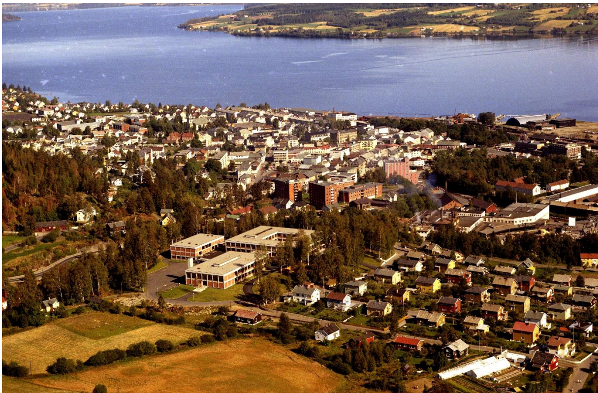
Gjøvik Tekniske Skole to år etter ferdigstilling. Bilde: Widerøe 1968
