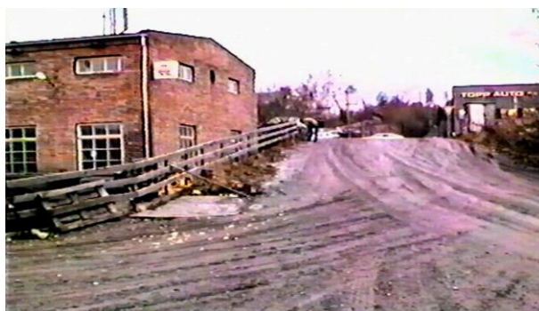
Fra bakgården til Curingsentralen og bakken opp til Strandgata. Bilder fra Vegvesenets film
