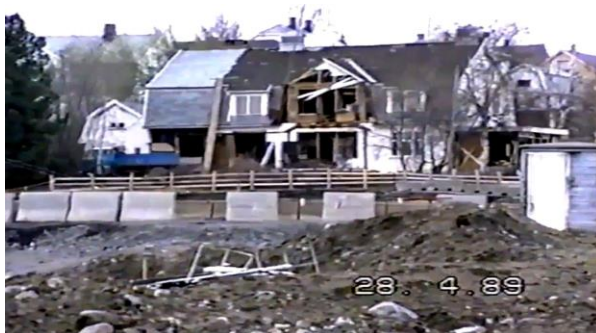
Fra riving av Odd Fellows lokaler i Sverresgate 1 Bilde fra Vegvesenets film
