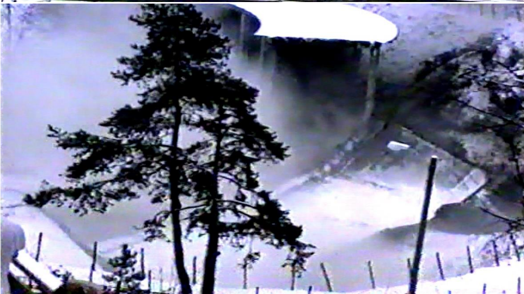
Nybrua sprenges 23. november 1990. Bilder fra Vegvesenets film
