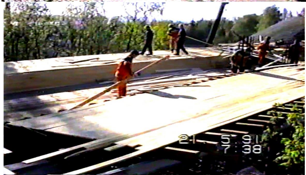
«Nye» Nybrua under bygging mai 1991. Bilde fra Vegvesenets film
