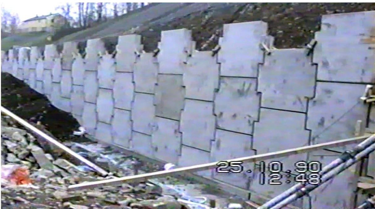
Som forstøtningsmur mot Hunton ble det benyttet et prefabrikkert system av engelsk opprinnelse som ble kalt «Reinforced earth». Bilde fra Vegvesenets film
