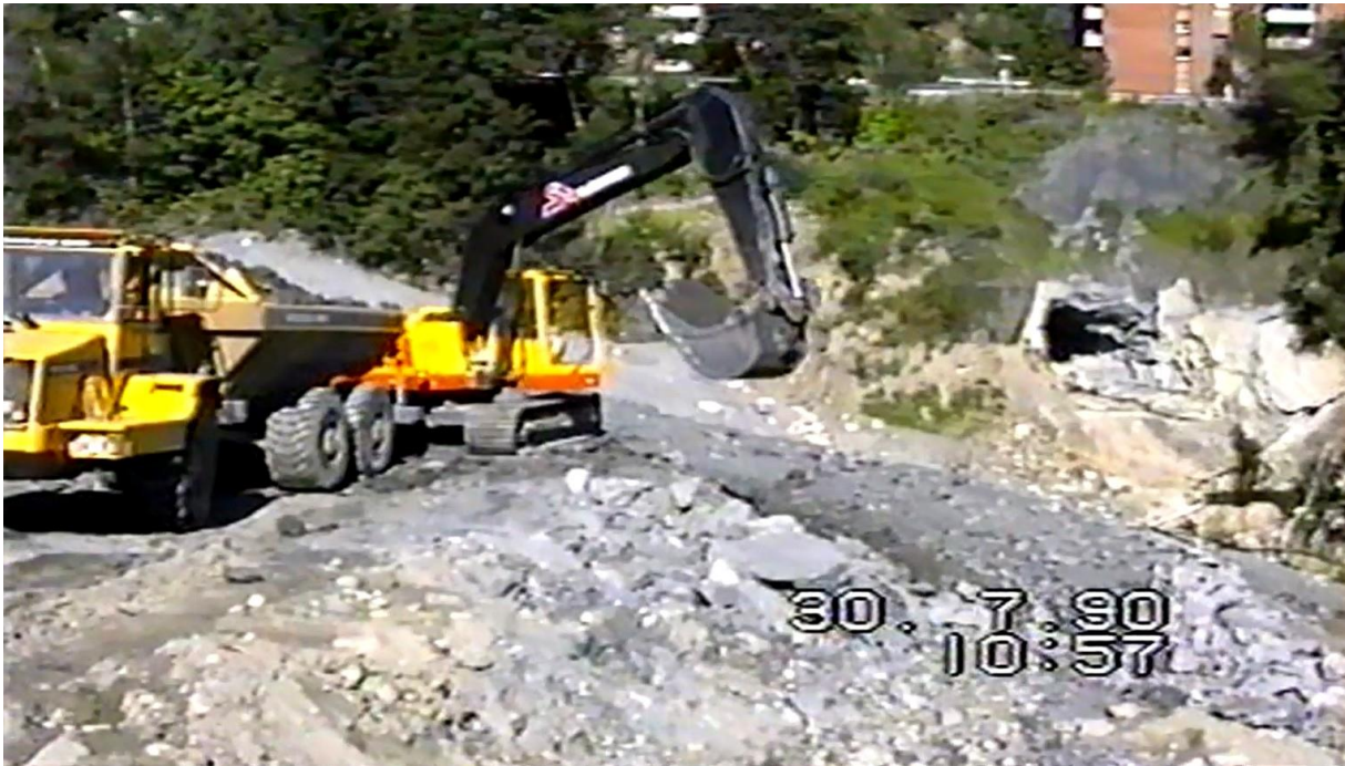
Anleggsarbeider utenfor tunnelutløpet ved Hunton 30. juli 1990. Den 400 meter lange tunnelen for omlegging av Hunnselva sto ferdig i april 1989. Bilde fra Vegvesenets film
