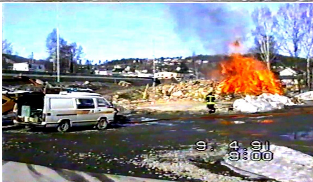
Graving i fjellmasser ved brua til Nygard stasjon. Riving og brenning av det gamle frørenseriet til Lilleengen. Bilder fra Vegvesenets film
