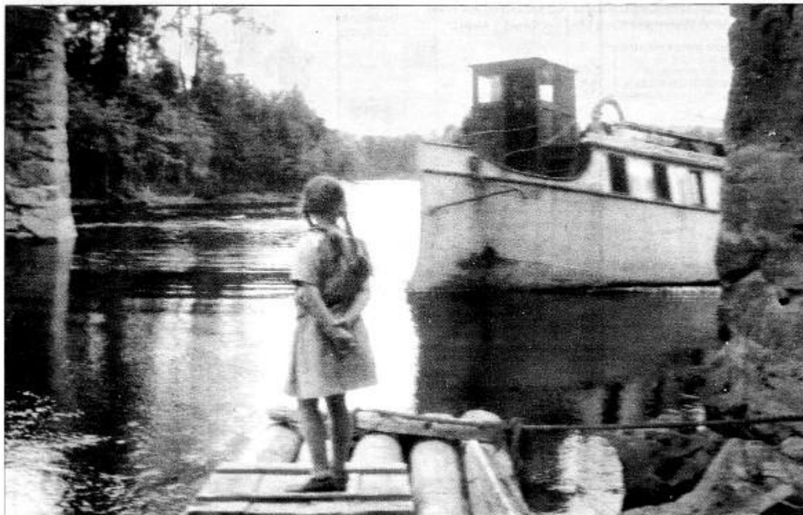
BODDE UNDER BRUA: Guri (i dag Gimse til etternavn) var født i «Dumpa» som fremdeles ligger der med taket stikkende opp over veikanten ved Osbrua.
