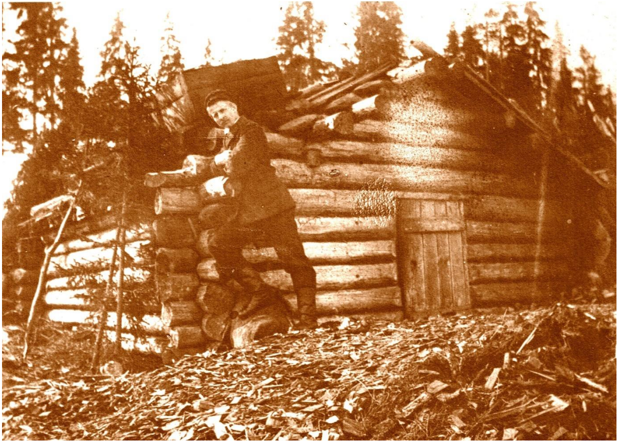
Olav Lommerud ved «Skanselund», Gråberget, Våler i Solør
