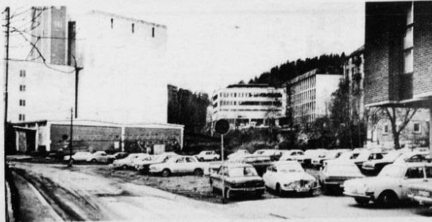
Her skal parkeringsanlegget i to etasjer bygges. Det blir innkjøring på øverste plan fra Storgata.
