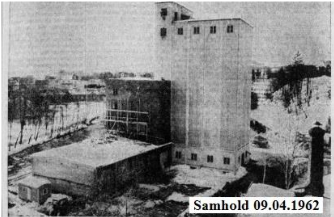
Det Andakset i kjerne Njorne nedre del ses påbegynnelsen av gravingen til den nye silobank med «Brennerbakken» i bakgrunnen. I disse dager rises stålrammen fra et tilbygg som ses litt t. v. på bildet.
