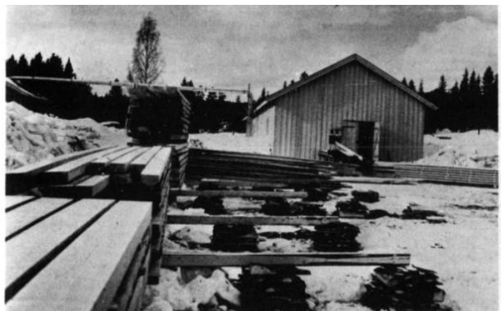
De første plankestablene tar til å gro opp utafor den nye saga.
