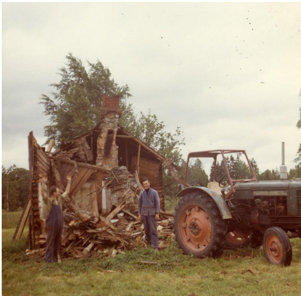
Tore Johnsson från Rotenäs nr 9, Ringevall och brodern Bengt Eriksson, Rotenäs nr 10, river Grunnstugan, Rotenäs nr 54.
