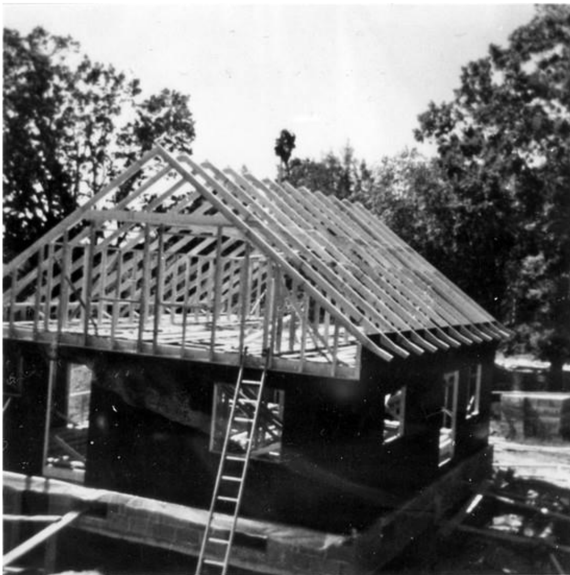
Huset i Rotenäs nr 11, Alskogen, under byggnad. Taget 1971.
