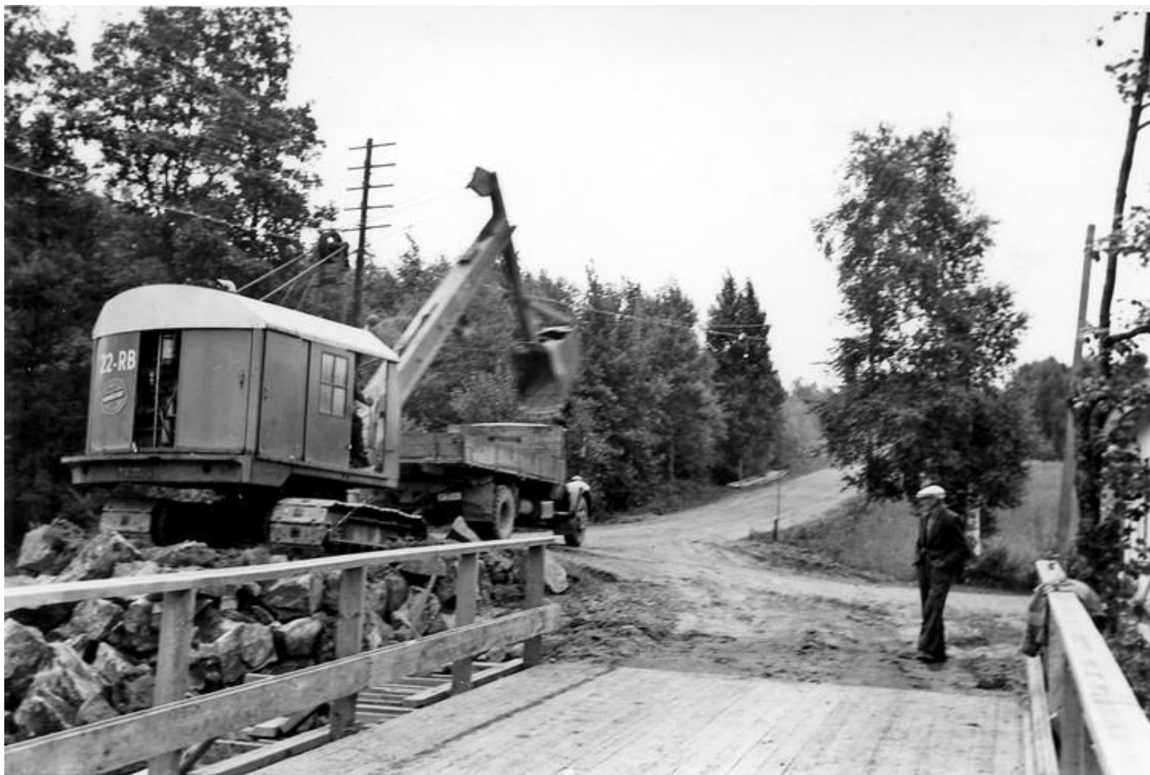
Grävningsarbete vid brobygge i Torsbo år 1954. Edvin Olsén, Rotenäs nr 39, är intresserad åskådare.
