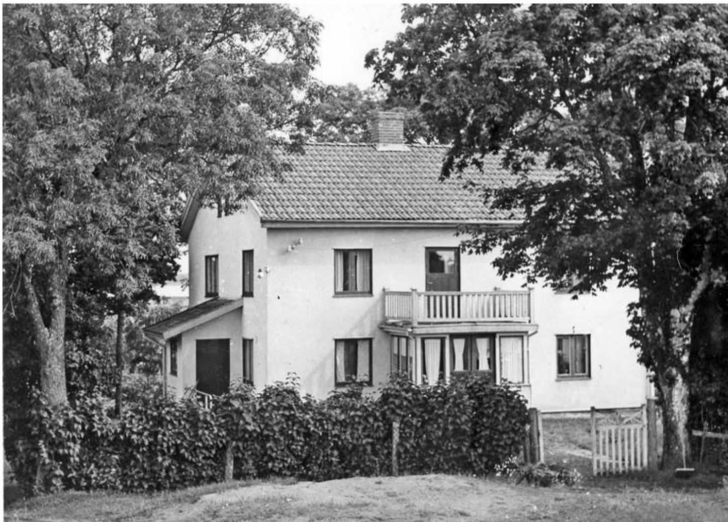
Den gamla Dalslandsstugan hos Albert och Ellen Deréhn, Binäs nr 5, Nolgården. Efter renoveringen på 1950-talet har fönstren bytts ut och fasaden reverterats, vilket helt förändrat husets utseende.
