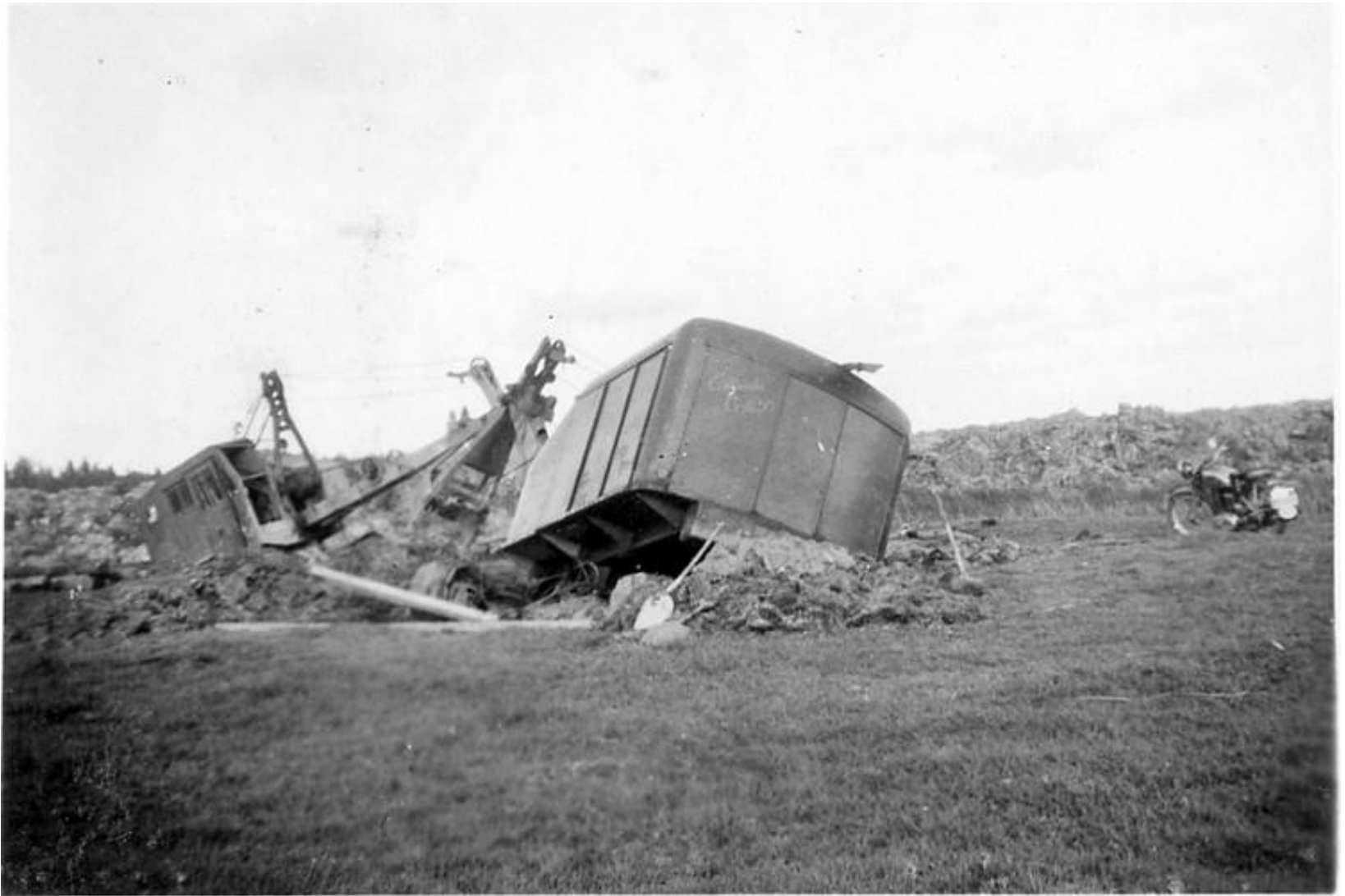
Grävmaskiner på väg att försvinna i gyttjan vid invallningsarbete 1955 vid Hästefjord nr 1.
