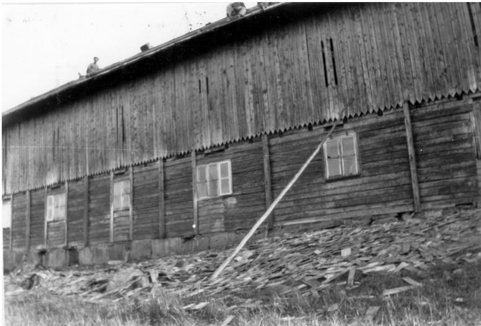
På den stora ladugården vid Hästefjord nr 1, pågår reparation av yttertaket.
