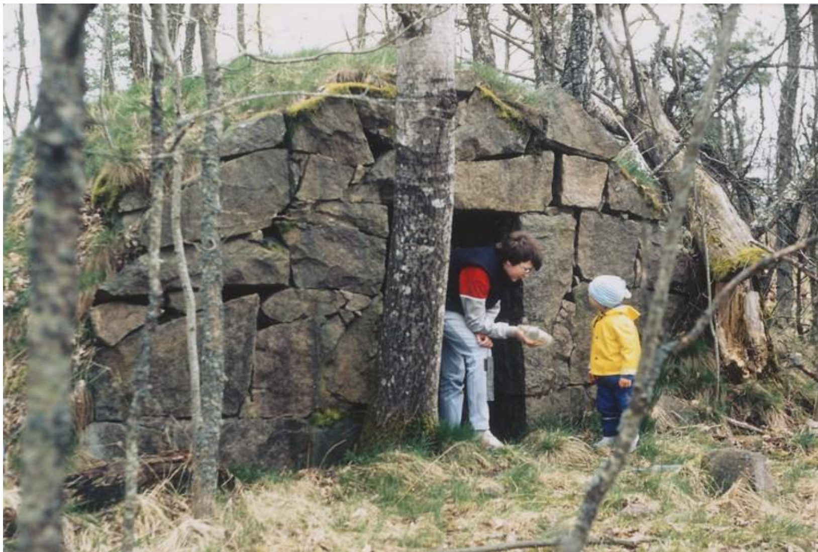
Stenkällare vid Skarbo nr 4, Dahlbergs. Källaren uppförd 1910. Foto taget 1/5 1992.
