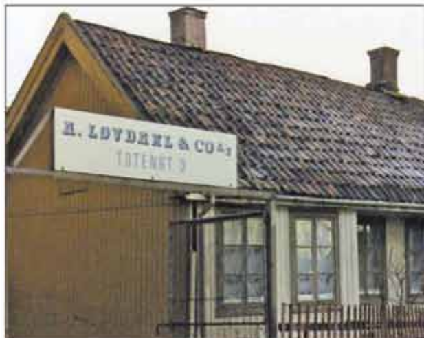
Før kvartalet med Totengata ble bygget ut, var Rosendal løkke her. Dette er løkkehuset. I dag er det et av de to gamle husene som ennå står. (Foto: Reidun Historielag).
