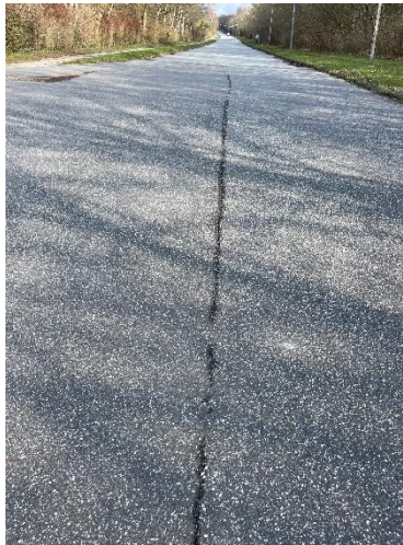
Billede 5: Længdesamling på hævet flade
