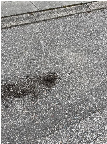
Billede 14: Afskalning på graverende
