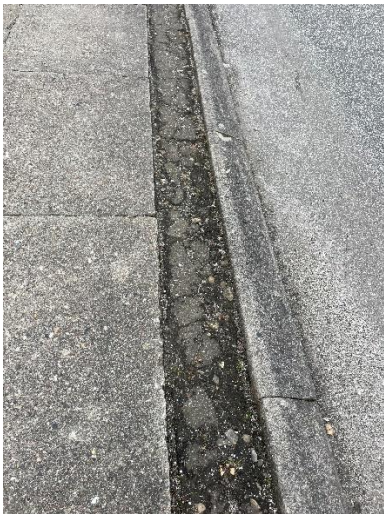
Billede 19: Asfaltbånd mellem kantsten og fortovsfliser
