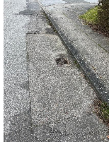
Billede 13: Lap uden slidlag
