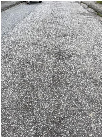
Billede 11: Stentab og krakeleringer
