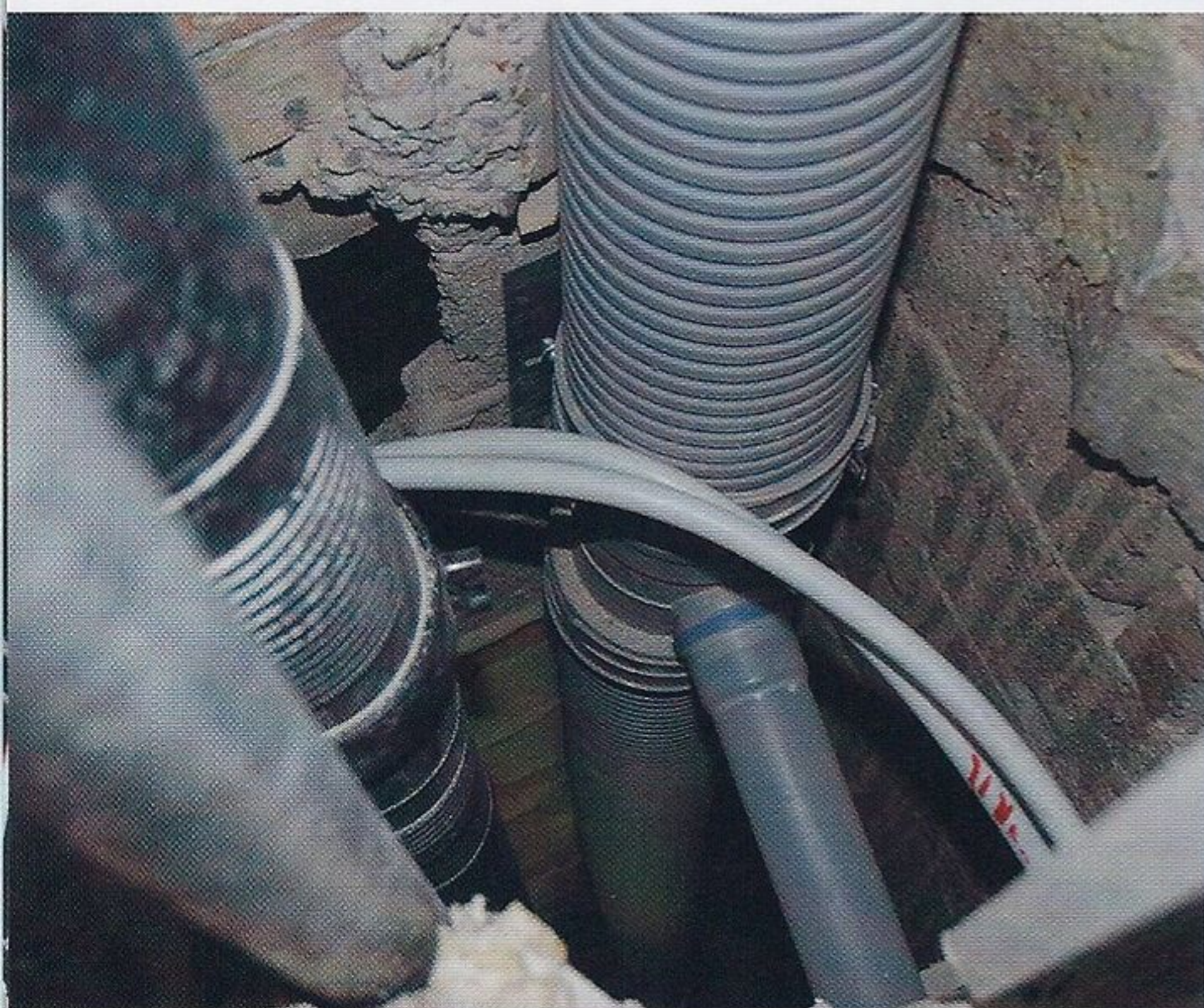
MultiFlex in bestaande schacht.
