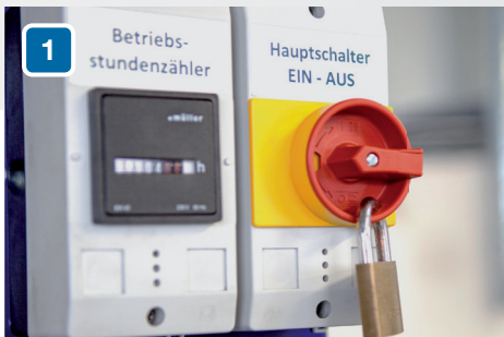
Schalter mit Wartungsschloß
