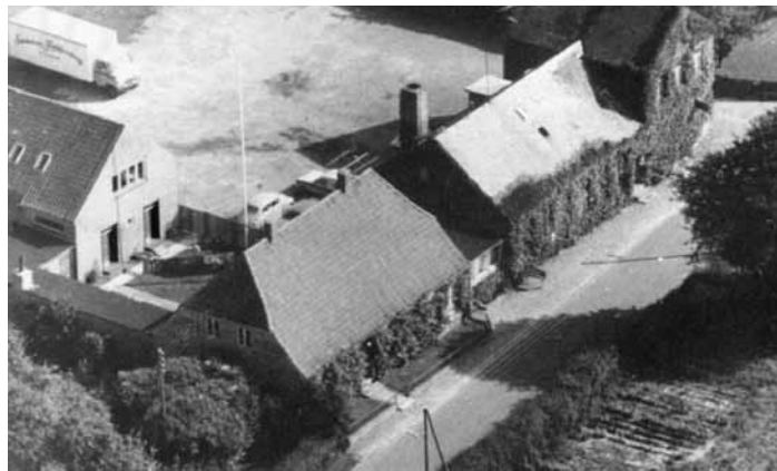
Kær Skole bygget i 1885.
