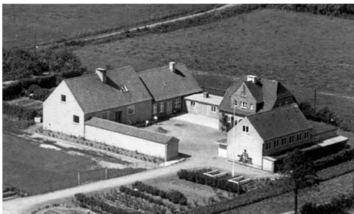
Huholt Skole bygget i 1895.
