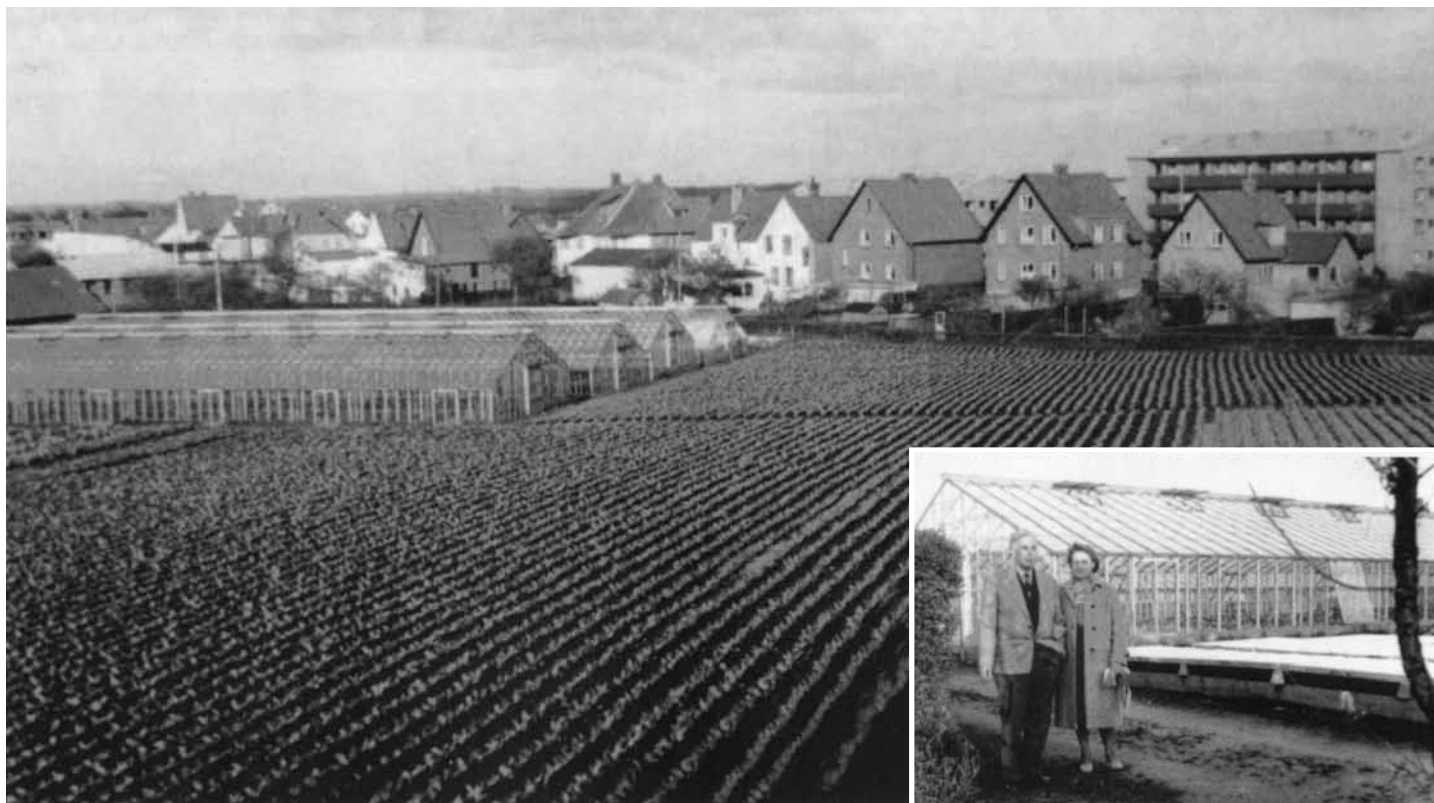
Gartneriet med Alsgade i baggrunden.
