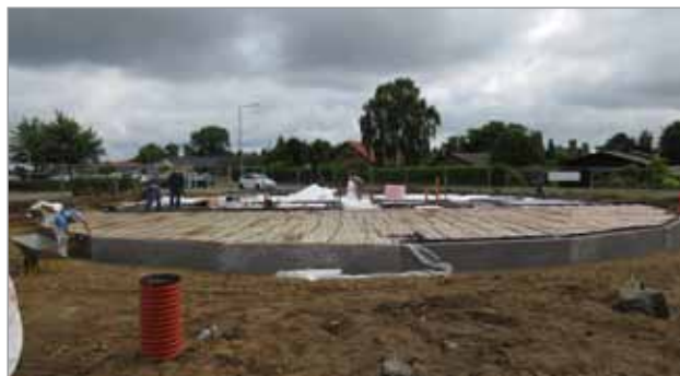
Fundamentet er støbt. Juni 2016
