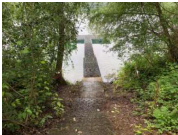
Bild 3: Befestigter Einstieg Widdauer See 2
