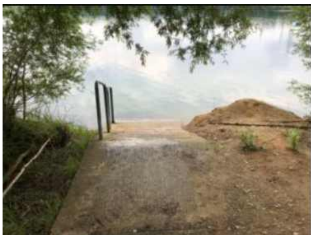
Bild 2: Befestigter Einstieg Widdauer See 1
