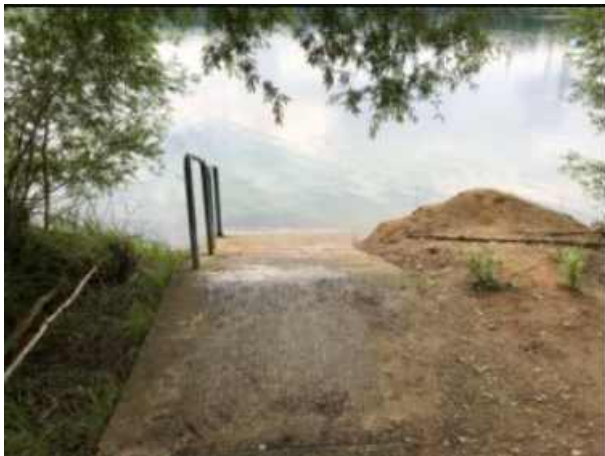
Bild 2: Befestigter Einstieg Widdauer See 1
