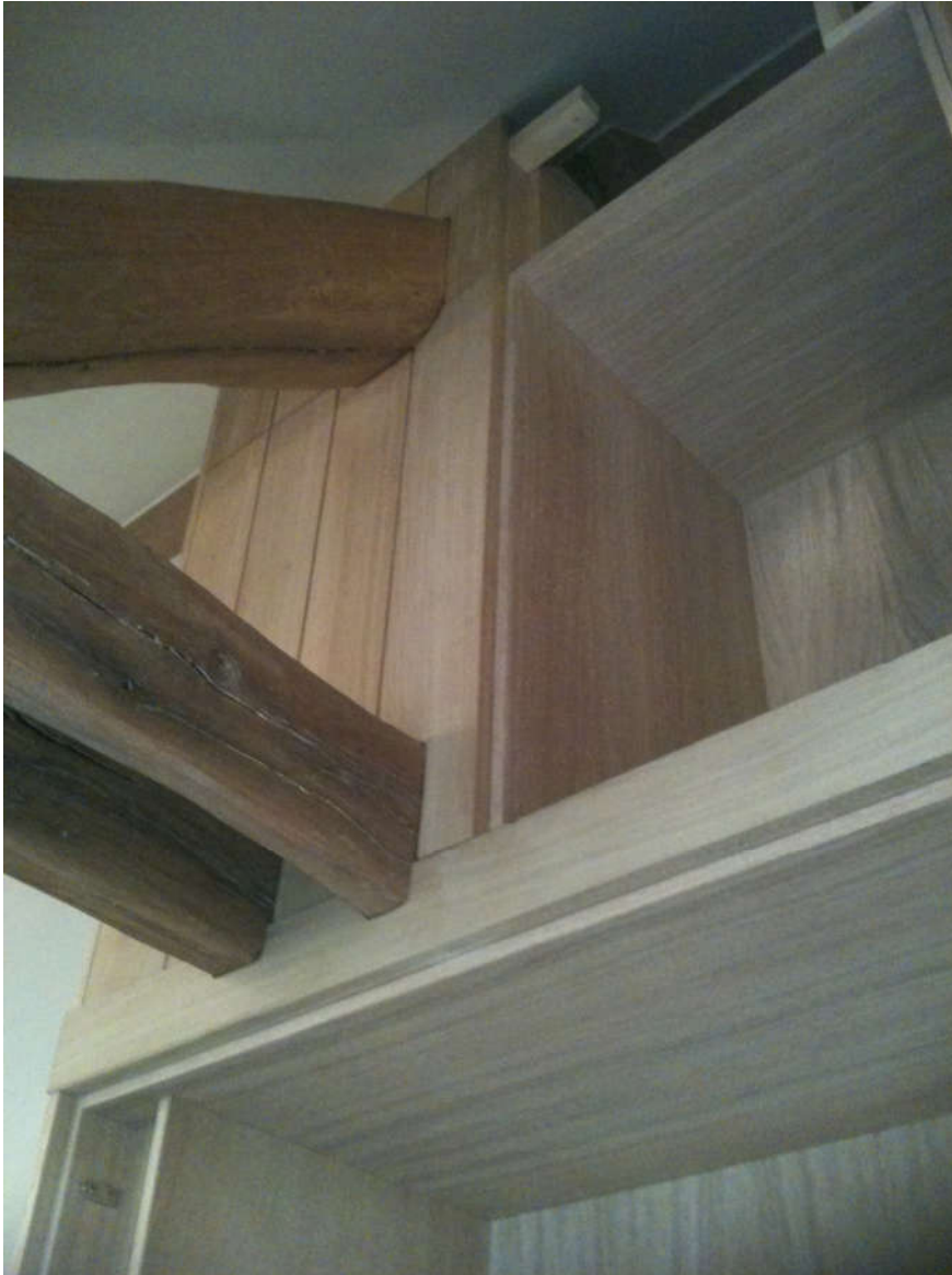
De massieve beplanking werd haarfijn rond het oude dakgebinte geplaatst.
