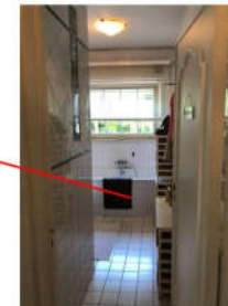
Uitbraak: kasten en bad, vloer, muurtegels, binnendeur, weggappen chappe tot op betonglaaf (voor nieuwe douche)
