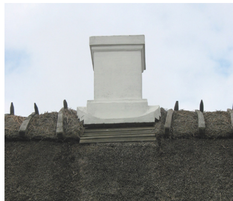
Skorstene kan eksempelvis genanvendes til udluftning
