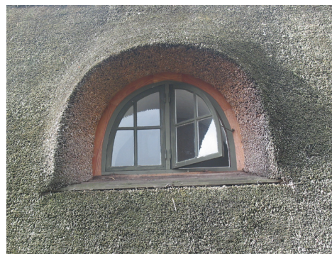
I stråtage bør kviste udformes som halvrunde udposninger af tagfladen
