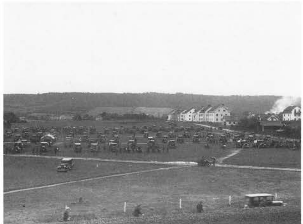
Upställning på Västra fältet. ( Th Gransikagatan, och rök från Kävplunda kalkbruk).
