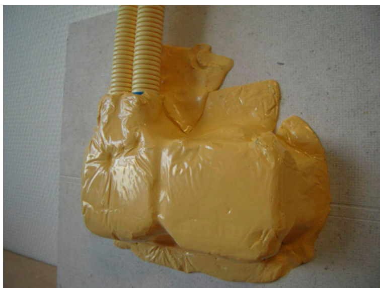
Foto 2 – Fernopatch aangebracht over de achterkant van een wandcontactdoos
