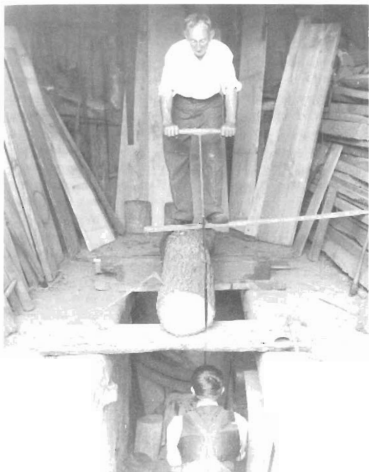
Fig. 31. — Een zaagkuil, in het Engels saw-pit, was eertijds algemeen bekend.
