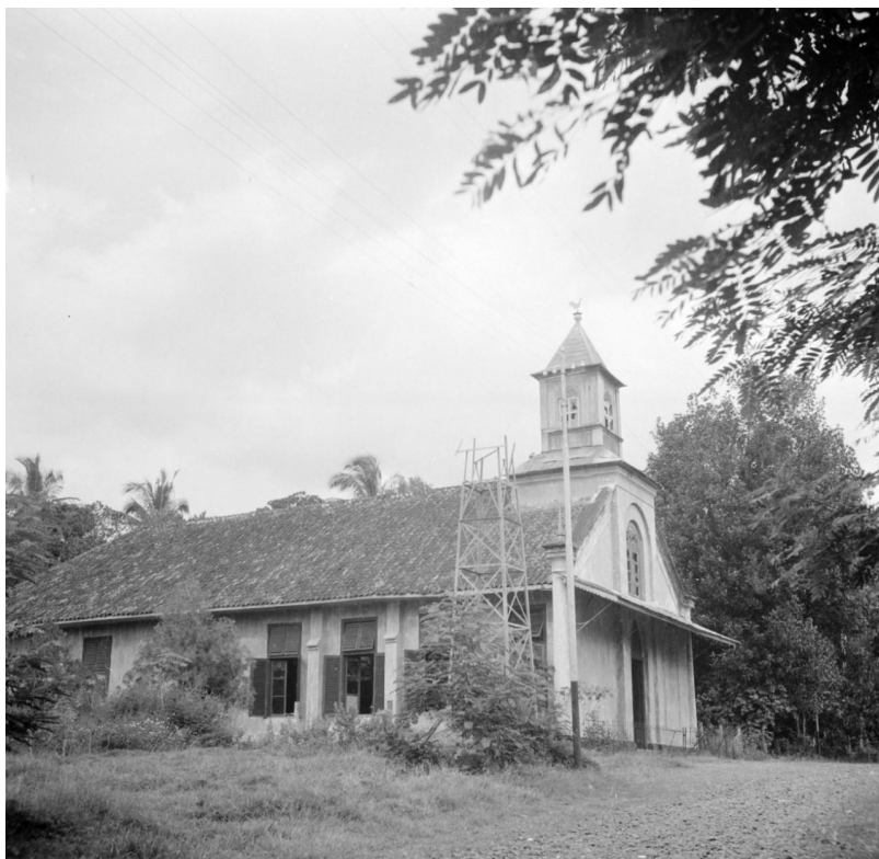
Afb. 28. De verwoeste kerk van Depok op 11 april 1946. De klok in de klokkentoren ontbreekt.
