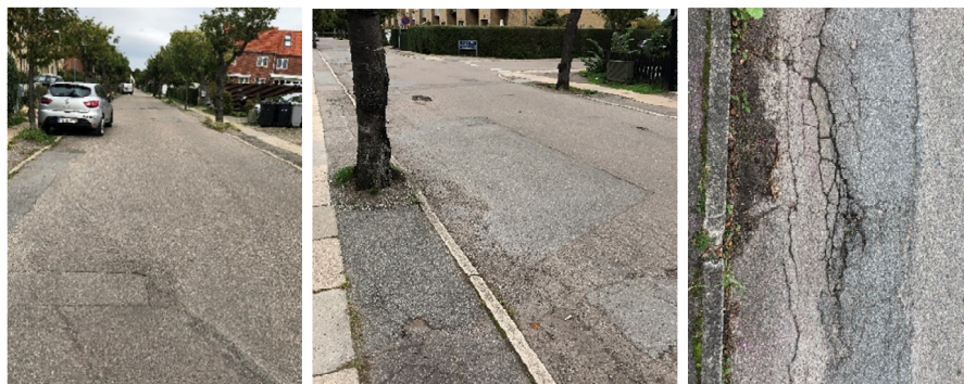
Figur 5 Krakeleringer og slaghuller på Snoghøj Allé med åbning ned til skærverne.
