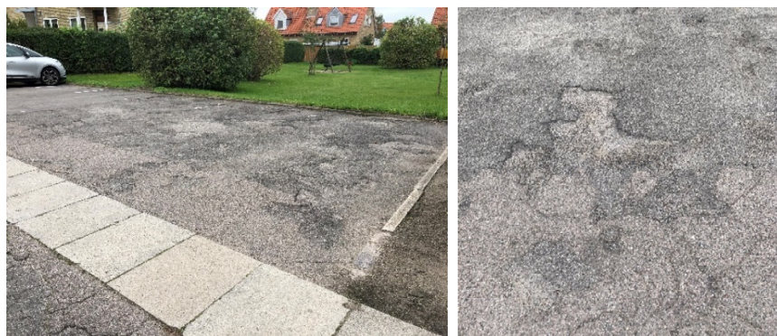
Figur 4 P-plads med afskalninger ved Jacob Appels Allé.
