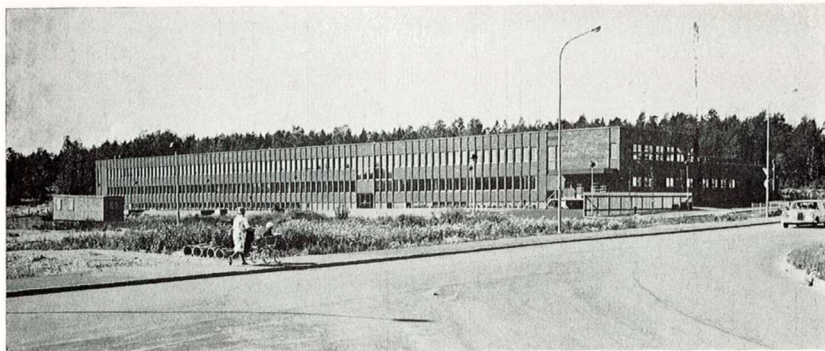
Företag: Yrkesskola i kvarteret Emsen, Rud. Byggherre: Drätselkammaren/CBK. Arkitekt: Havstad Hollström Lindell AB, Arkitekter SAR.
