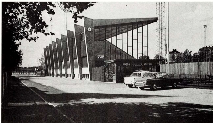
Företag: Läktarbyggnad Tingvalla Idrottsplats, Klara. Byggherre: Karlstad stads Idrotts- och Friluftsnämnd. Arkitekt: Orrje & Co Scandiaconsult AB.
