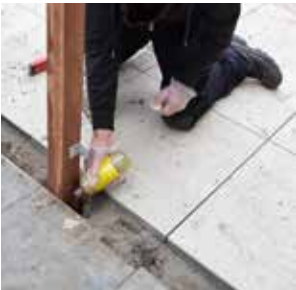
Mengsel in paalgat gieten
