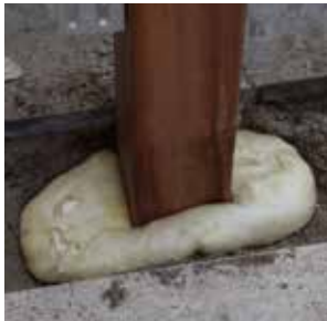
De paal staat binnen 3 minuten muurvast
