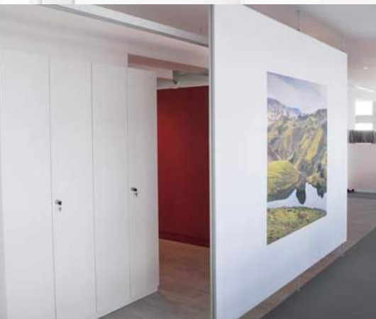
beidseitige Textilabspannung zur Trennung von Büro und Flur
