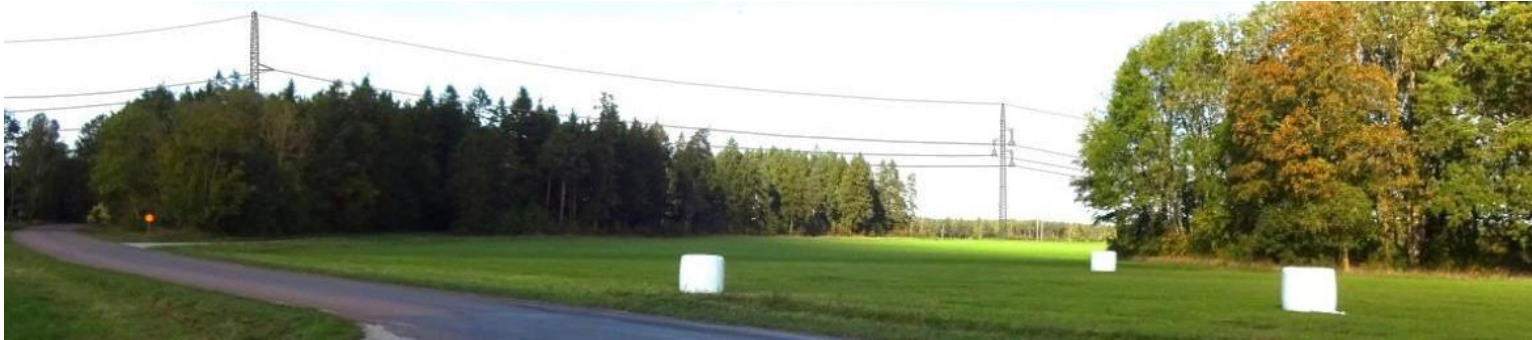
Fotomontage av en gitterstolpe med en enkelledning
