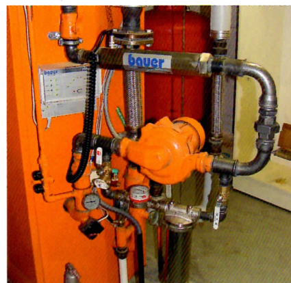
Installation direkt på röret
