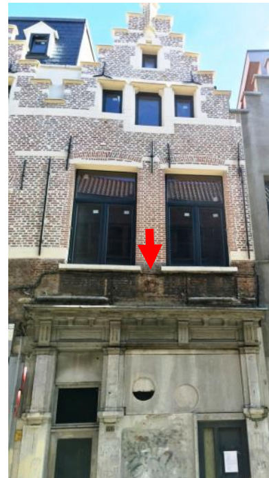
Fig. 4. huis In de Kemel , Lange Nieuwstraat 152 (opname juli 2016).
