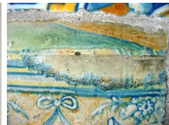
Tegel U2: gevloeid glazuur en overstraling?
