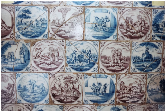
Foto A.19: KA0517>0520 & KA0416>0420 & KA0317>0320
