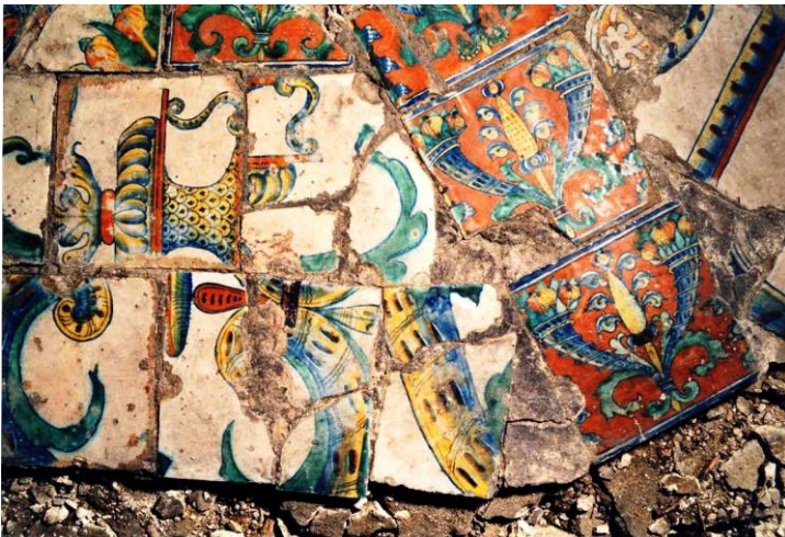
Tegelbreuk en met mortel dicht gestreken breukgroeven.
