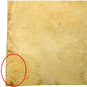
B02100: afgesneden X-inkerving aan de linkerboord van de tegel, C06050: X-inkerving onder het glazuur in de hoek rechtsonder.
