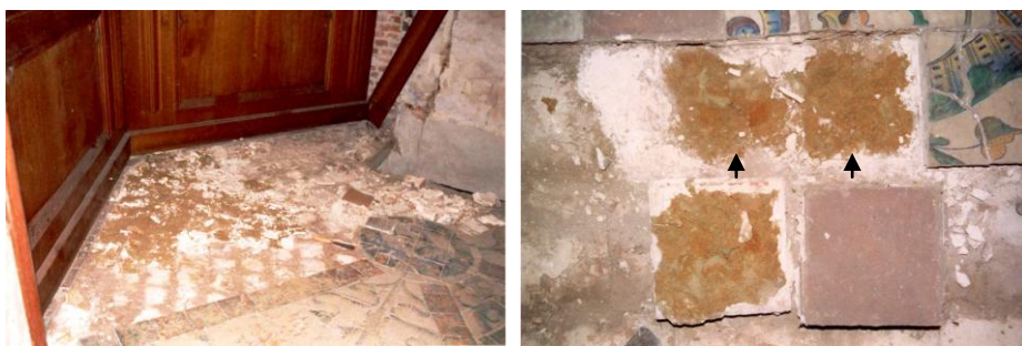
Identieke zavelbedding onder de lacune in zone B (links) en onder de twee rode tegels in zone F (rechts).
