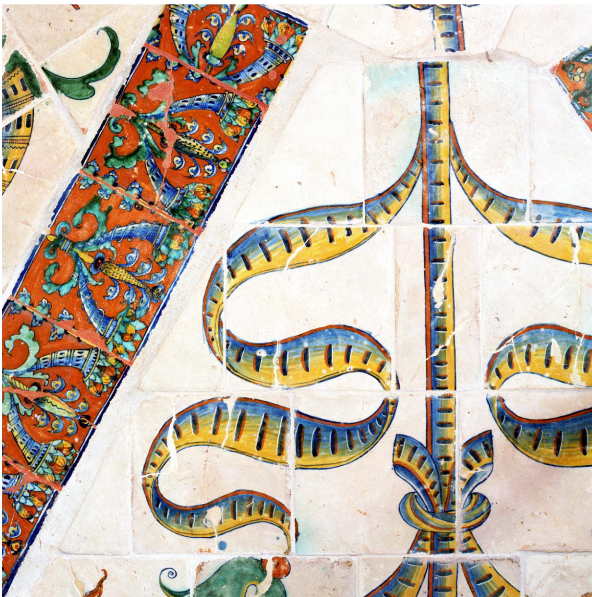
Drie verschillende tegelvormen: vierkant, rechthoek en driehoek - detail uit de gerestaureerde zone E.
