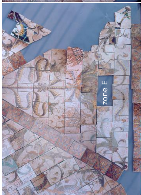
Maquette uit miniatuurtegeltjes van de zones E, F en M, met definitieve bestemming van alle beschikbare tegels, plus assemblage van de hele vloer.
