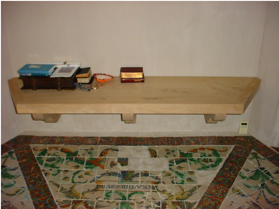
Zitbank rechts in de kapel steunend op een console verankerd in de muur zodat de majolicavloer vrij blijft.
