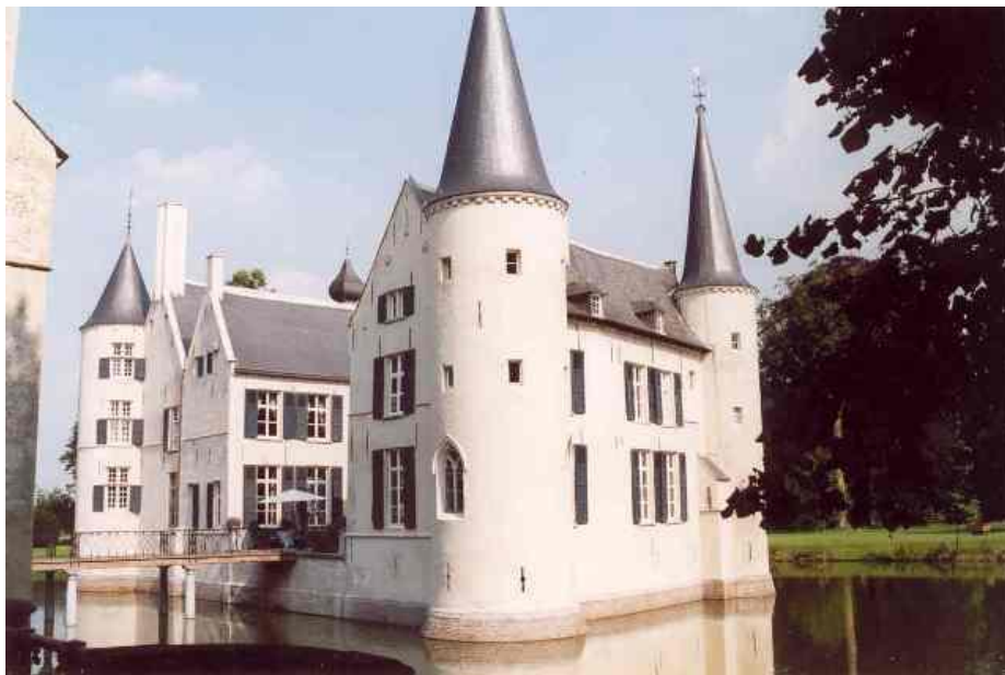
Zicht op de noordwest georiënteerde voorgevel van het kasteel. Op het voorplan de kapeltoren.
