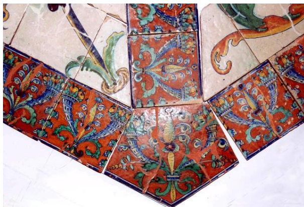
De vijfkanttegel vormt het verbindingstuk voor drie rijen randtegels.
