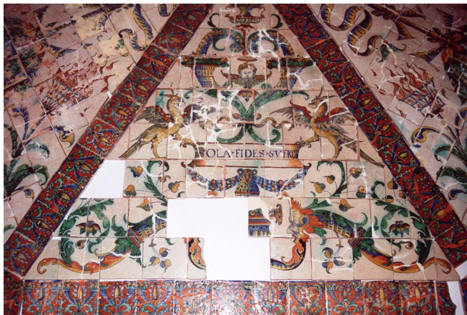
Het groteskendecor in zone F. Reconstructie met de gerestaureerde tegels.
