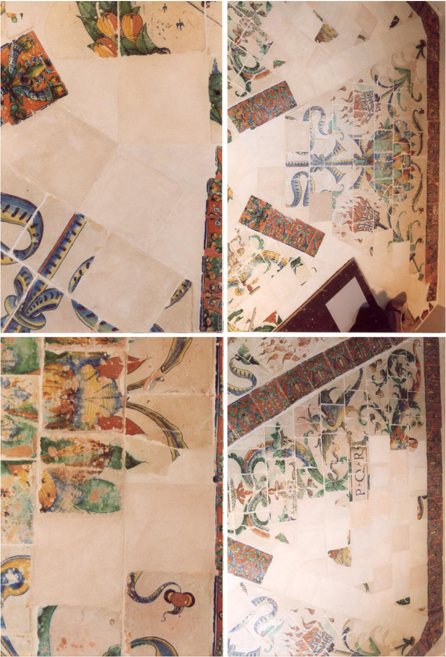
Aanvulling van de lacunes met kalkmortel van hydraulische kalk en fijn gezeefd zand, afgetekend als afzonderlijke kleurcontrasterende tegels.
