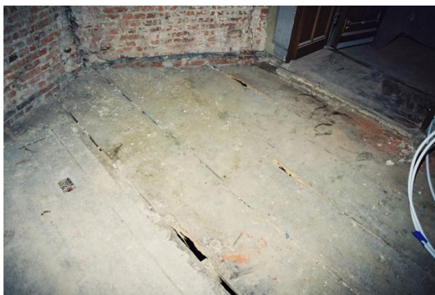
De houten vloer na verwijdering van de tegels en zavelbedding. (Foto R. Steenmeijer)
