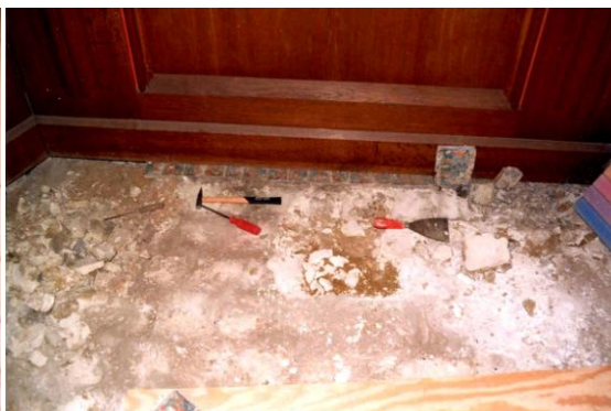
Gebruikt werkmateriaal bij het verwijderen van de tegels; tevens beeld van de kalkmortel- en zavelbedding.
