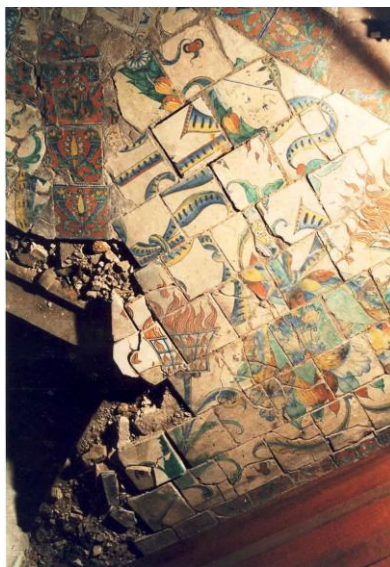
Tegels uit de bovenste helft van zone C die willekeurig werden teruggeplaatst én recente [1994] tegelbreuk ontstaan bij het verwijderen van het altaar.
