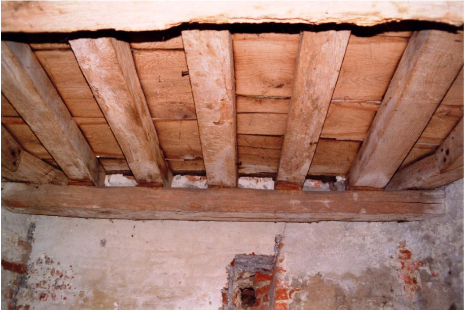
De houten vloerconstructie gezien van uit de kelderruimte.
