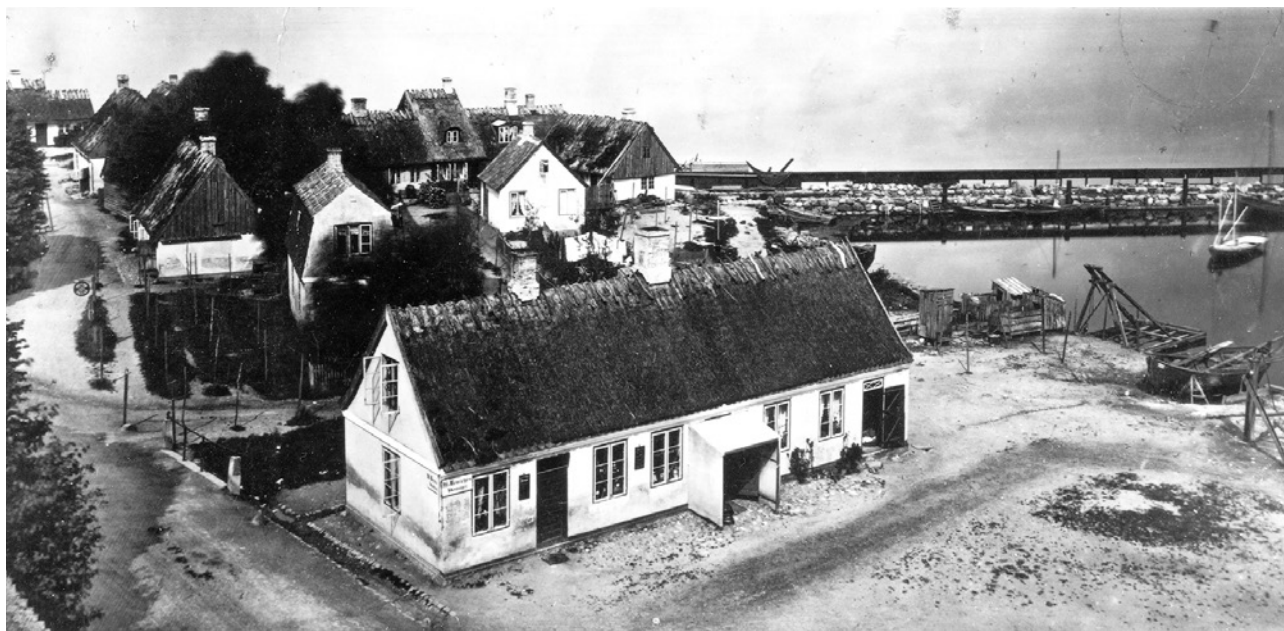
De ældste huse som blev beskyttet af nordre mole. Tors bæk, som er ført under Taarbæk Strandvej, er det mørke område bag det forreste hus (nu Ndr. Molevej). 1870.
