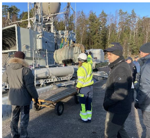
Kappen lyfts inför byte av GT5:an
