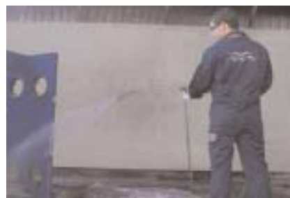
9. Stativunderhåll. Om så erfordras, inspektion och trycktvätt av stativ och inkapsling. Sandblästring och målning är tillval.
