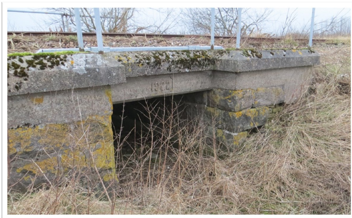
04 – 43,9 km | ved OK 97.
