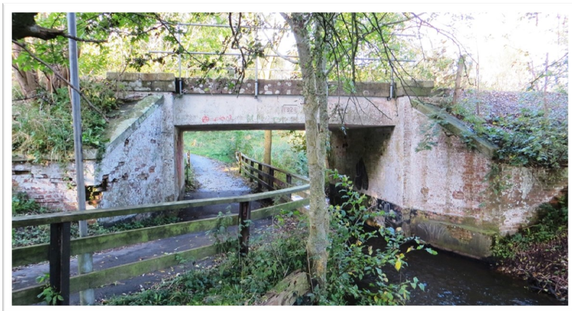
20 – 65,9 km | bro/viadukt ved Vidå broen, vest for OK 127.
