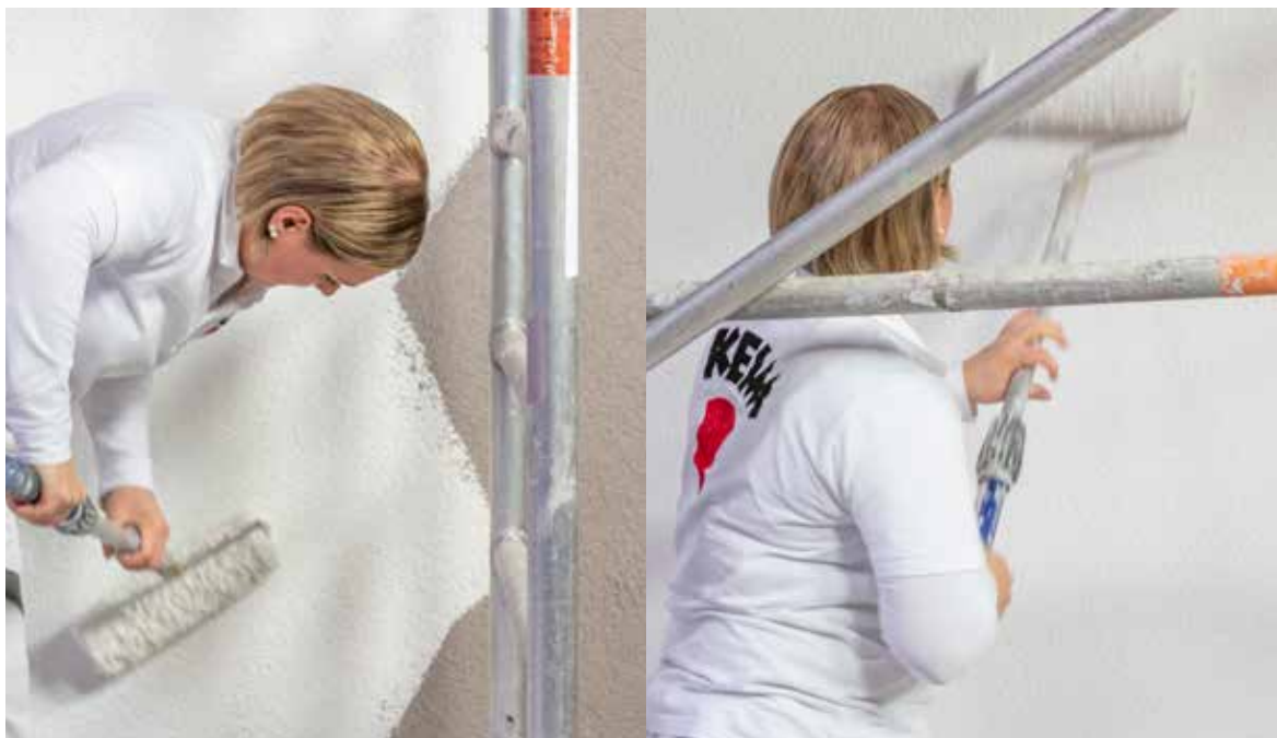
1. Påfør et mættende lag maling. 2. Rul et lag maling mere i lige lodrette linjer. 3. Færdig!
