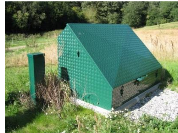
Kilde: Djurs Vand. Råvandsstation.
