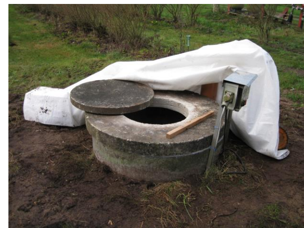
Kilde: Enkeltindvindingsanlæg, Tørbrønd.
