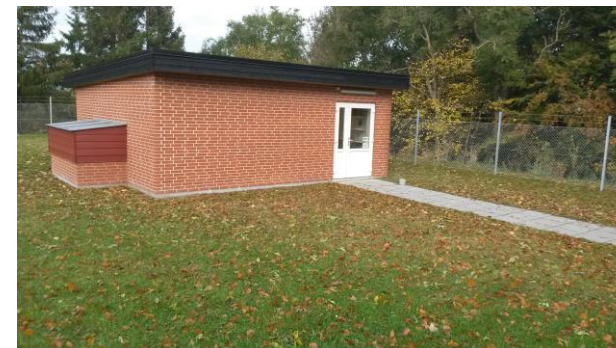
Kilde: Balle Vandværk. Vandværksbygning.
