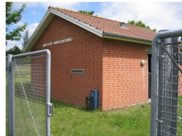
Kilde: Helgenæsvand. Vandværksbygning.
