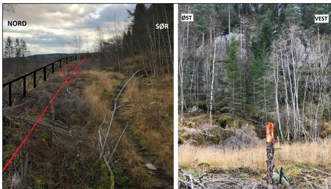
Figur 13 Plassering av sikringsgjerde ved påle nr. 06. Foto 16.11.18
