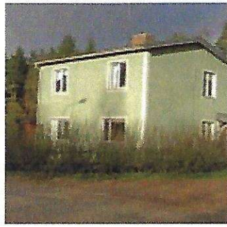
Grönkulla Kinda kommun Byggt 1936 av Gullringens konsumtionsförening. Ursprungligen fanns konsumaffären borta vid Hällefors. Föreståndare under en lång följd av år var Karl Nilsson, en välkänd Ydreforsbo. Den siste handlaren i denna affär hette Sven Johansson som köpte huset och drev affär där till slutet av 60-talet. Det ägs idag av Ananda Marga. Foto: © Stig Blomberg i november 2006
