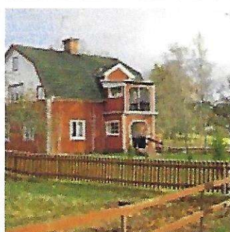
Sjöhaga Kinda kommun Byggt 1924. Till en början fanns här en kaféörelse. Foto: © Stig Blomberg i november 2006
