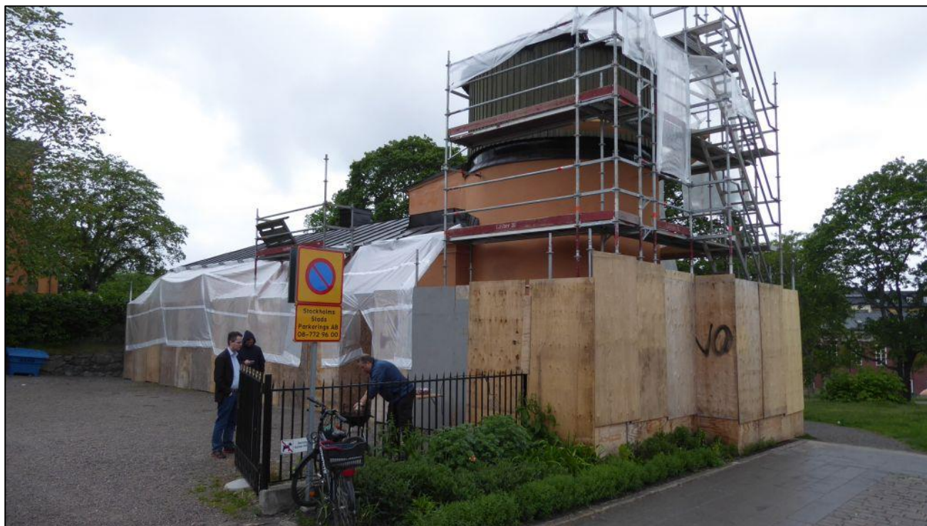
Fasadrenovering av Magnethuset sommaren 2019. Foto Göte Flodqvist
