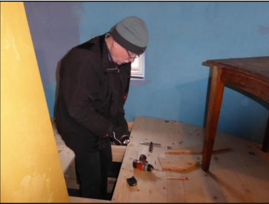
Nu är första lagret av 22 mm golvbrädor nästan klart. (GF)
