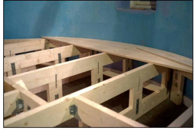
Här har golvbrädorna börjat läggas på. Väggens runda form komplicerar bygget. (HCP)
