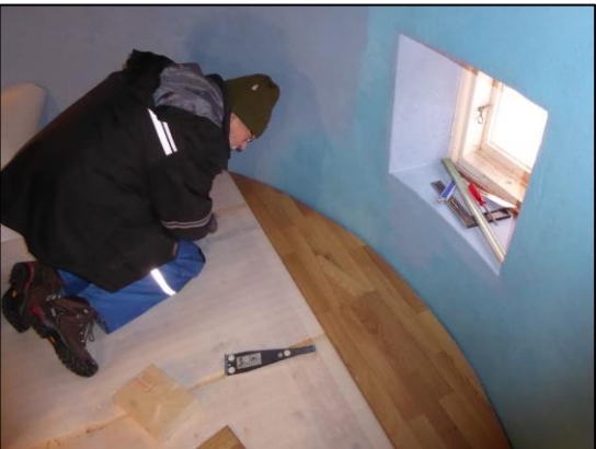
På det färdiga undergolvet läggs först golvplast och ovanpå det parkettlaminat. Gunnar och Göte stod för detta jobb. (GF)
