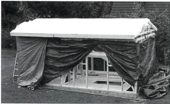
Takstommen med kondensduk
