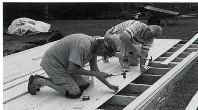
Gunnar Lövsund (t v) och Åke Karlsson lägger golv
