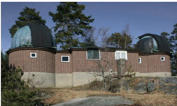
Meridianhuset från söder
