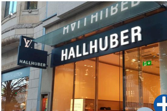
Flache Kastenkonstruktion mit aufgesetzten Buchstaben
