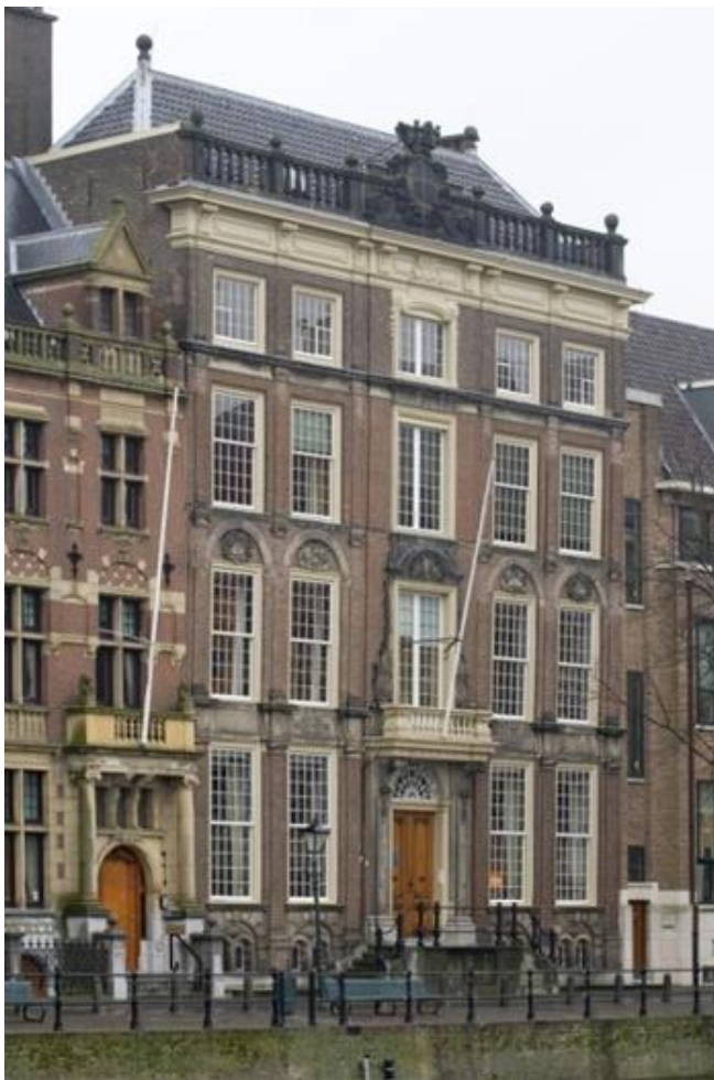
Korte Vijverberg 3, Den Haag. In 1635 betrok de vermogende Reinier Pauw dit grote pand. Het werd toen in de volksmond 'Huis Pauw' genoemd. Tegenwoordig is hier het Kabinet van de Koning gehuisvest.
