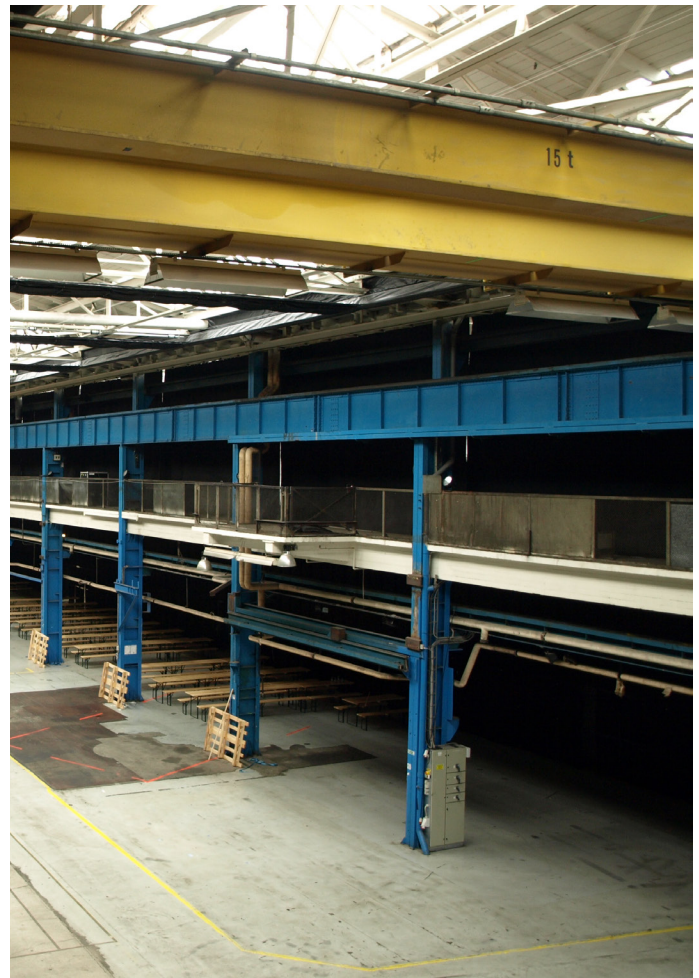
Stålkonstruktioner i Hal 14
