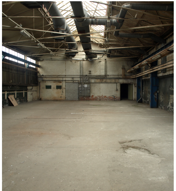
Betongulv i dag
